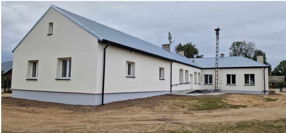
Rysunek 23 Budynek świetlicy wiejskiej w miejscowości Nowa Wieś k. Duczyna
