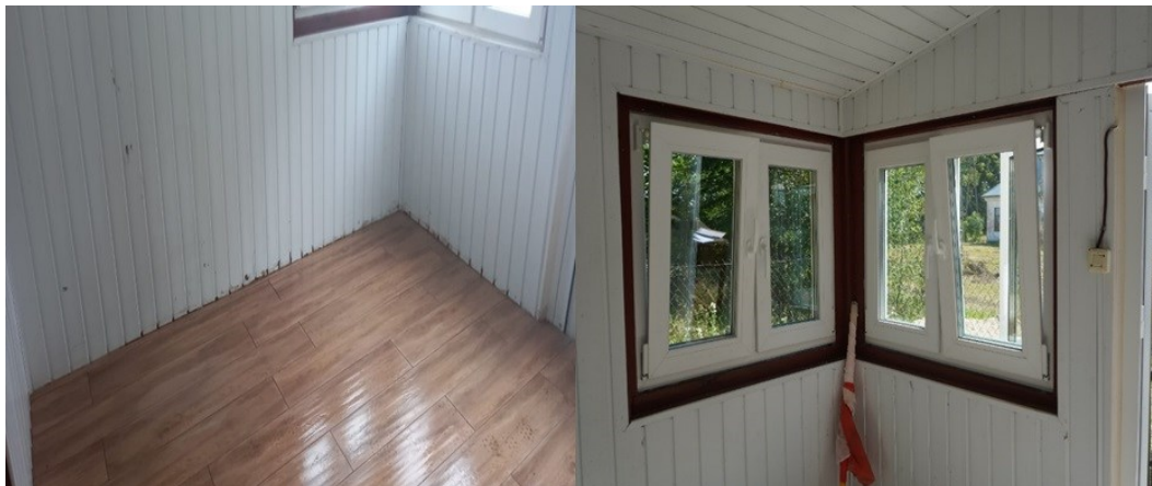
Rysunek 37 Wyremontowana podłoga oraz wstawione dwa okna w świetlicy wiejskiej w Rawkach
