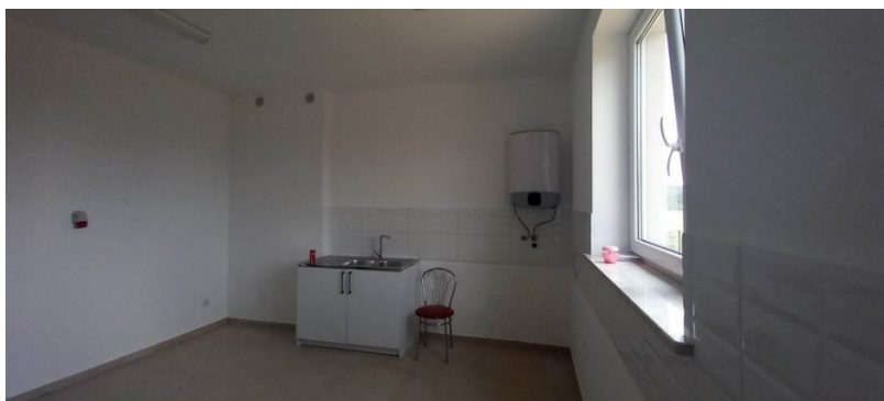
Rysunek 40 Wyremontowana kuchnia w świetlicy wiejskiej w Duczyminie
