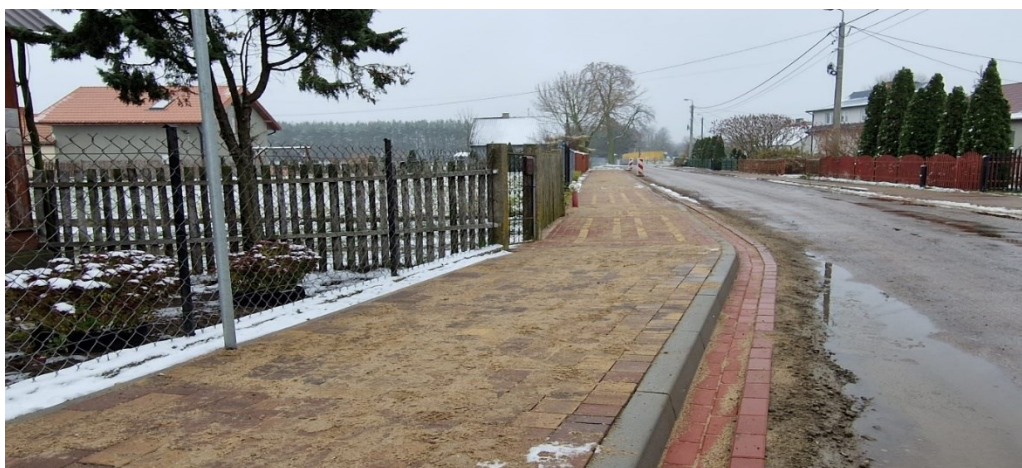
Rysunek 17 Droga gminna nr 320125W (relacji droga gminna Chorzele- Pruskołęka- Żelazna)
