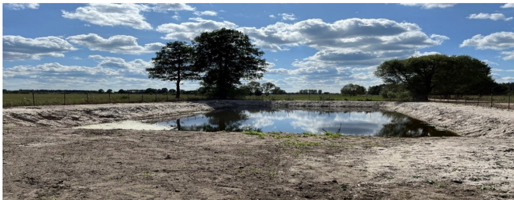
Rysunek 33 Zmodernizowany zbiornik przeciwpożarowy w Zarębach, źródło: Urząd Miasta i Gminy w Chorzelach
