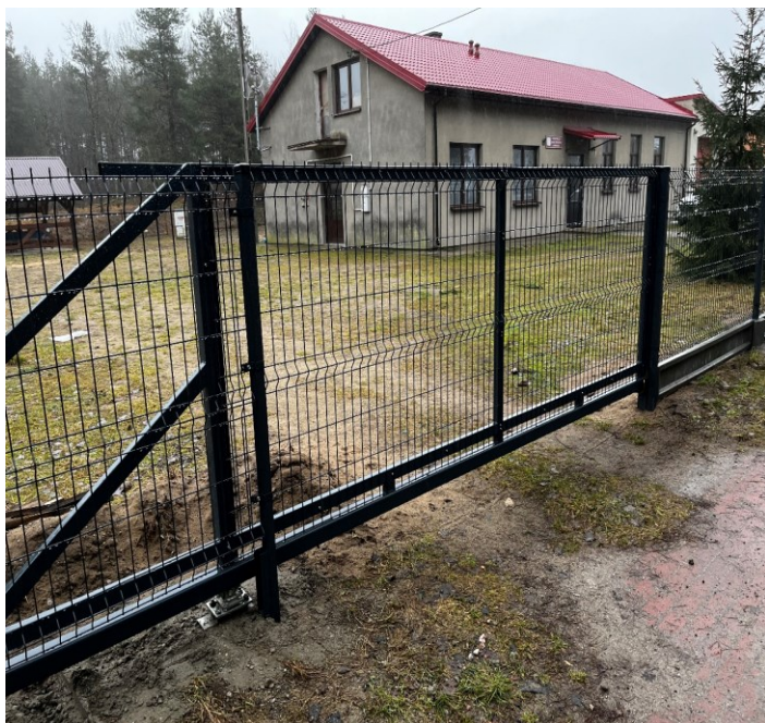
Rysunek 30 Ogrodzenie z przęseł panelowych w miejscowości Budki, Źródło: Urząd Miasta i Gminy w Chorzelach.
