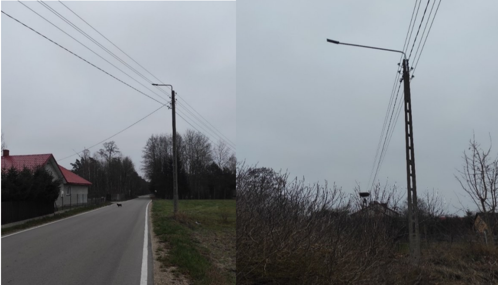
Rysunek 62 Dowieszono oprawy oświetlenia ulicznego LED o mocy 45W w miejscowości Opaleniec, Źródło: Urząd Miasta i Gminy w Chorzelach.
