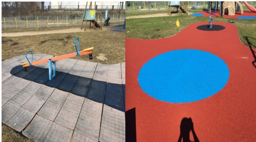
Rysunek 42 Starą nawierzchnię z płyt zastąpiono poliuretanową nawierzchnią bezpieczną wylewaną SBR i EPDM. źródło: Urząd Miasta i Gminy w Chorzelach
