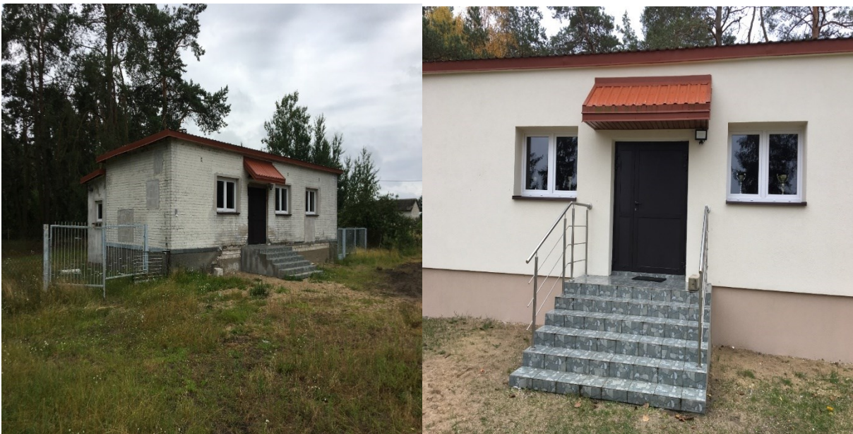
Rysunek 55 Budynek świetlicy przed i po remoncie w miejscowości Poścień Wieś, źródło: Urząd Miasta i Gminy w Chorzelach
